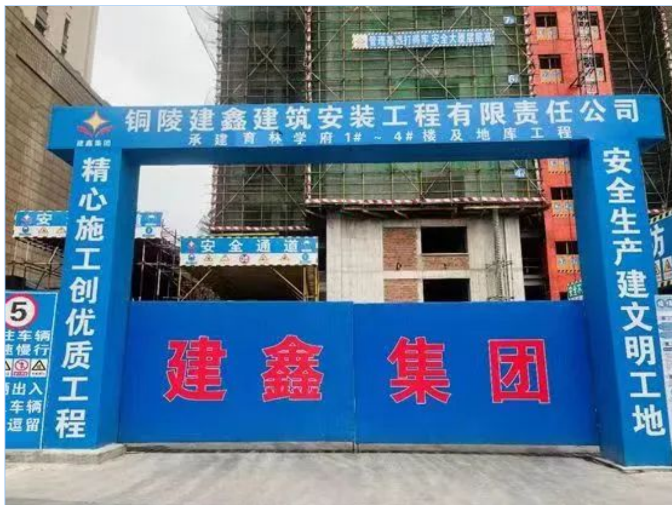
毓秀学府1#-4#楼及地下室工程
