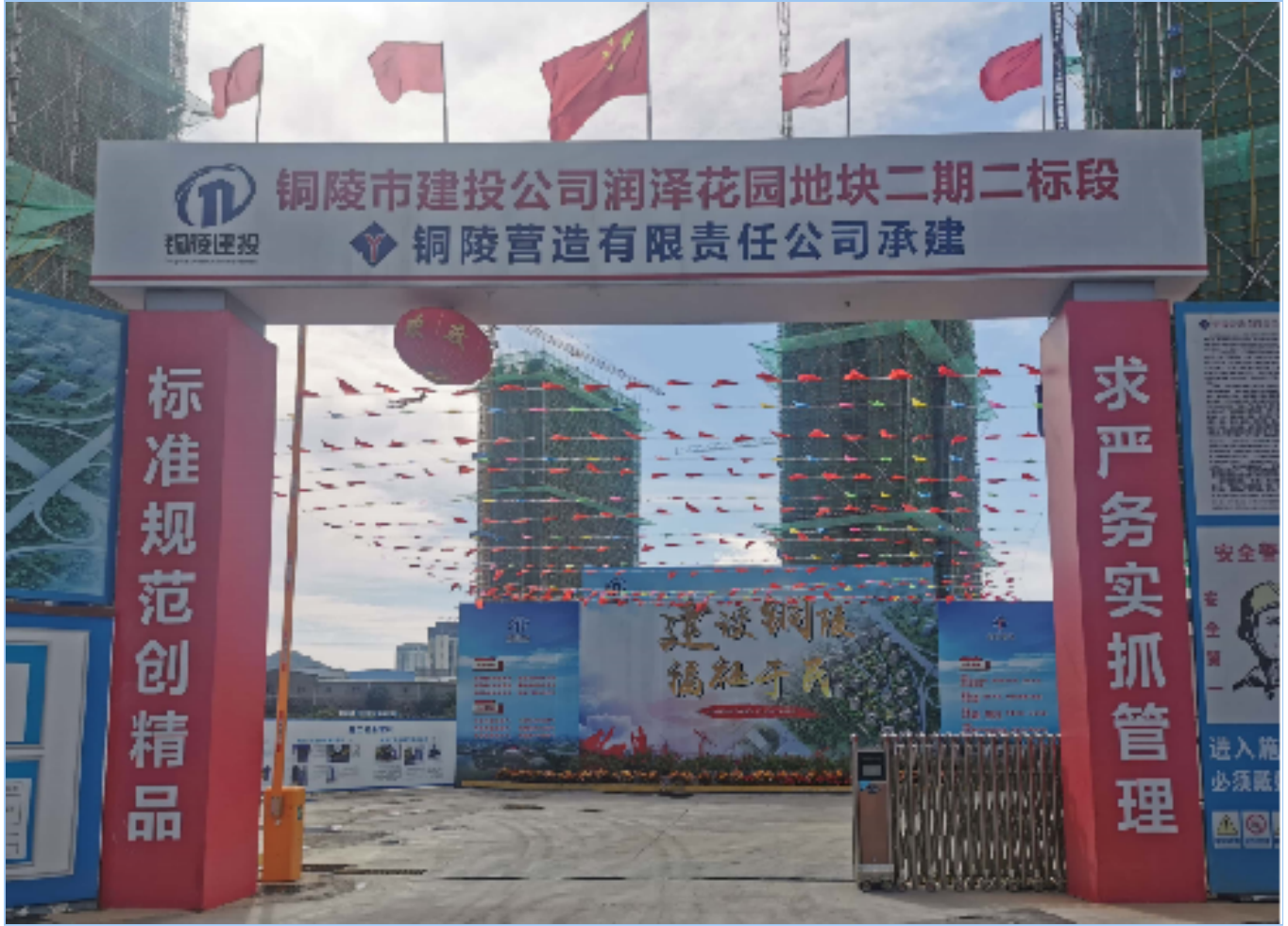
润泽花园小区（鱼头地块安置点二期）二标段工程
