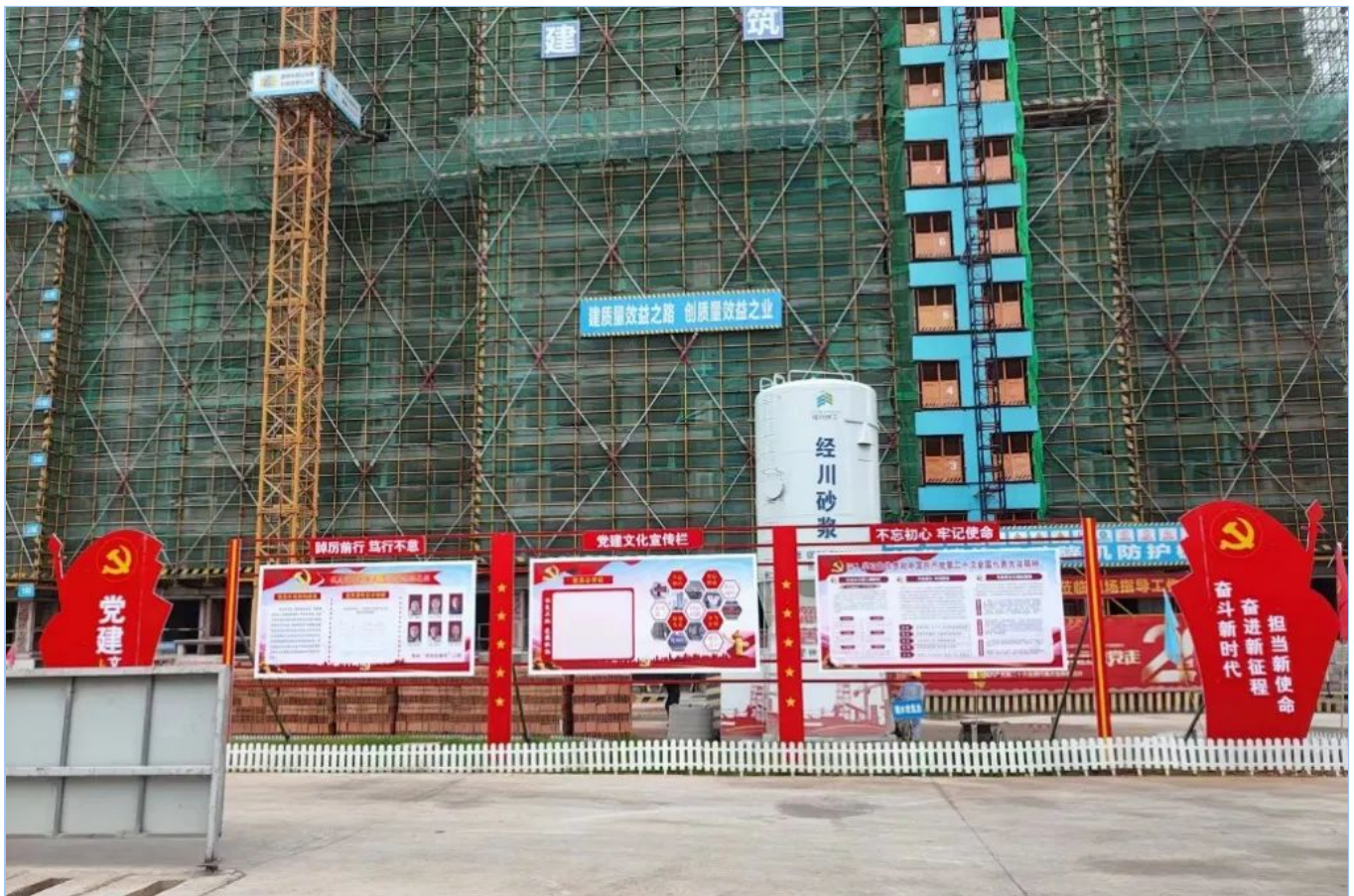
君悦华府15#、16#楼、开闭所、门卫消控室及人防地下室工程
