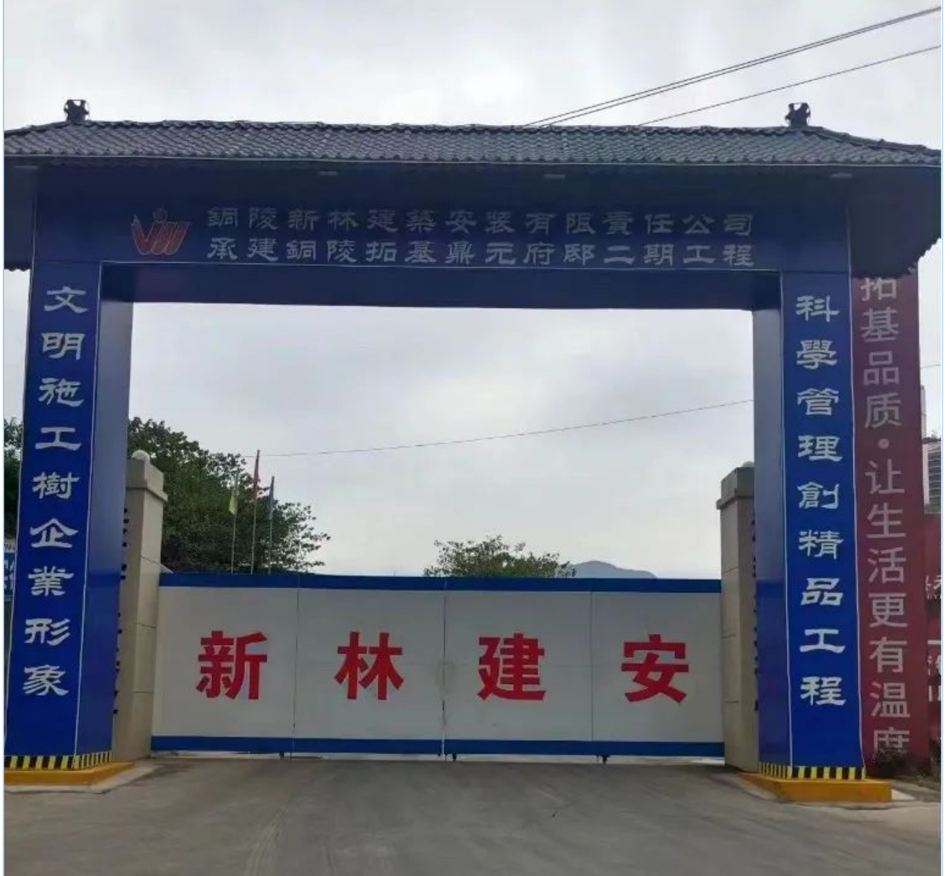
拓基鼎元府邸二期9#、10#楼及地下车库工程
