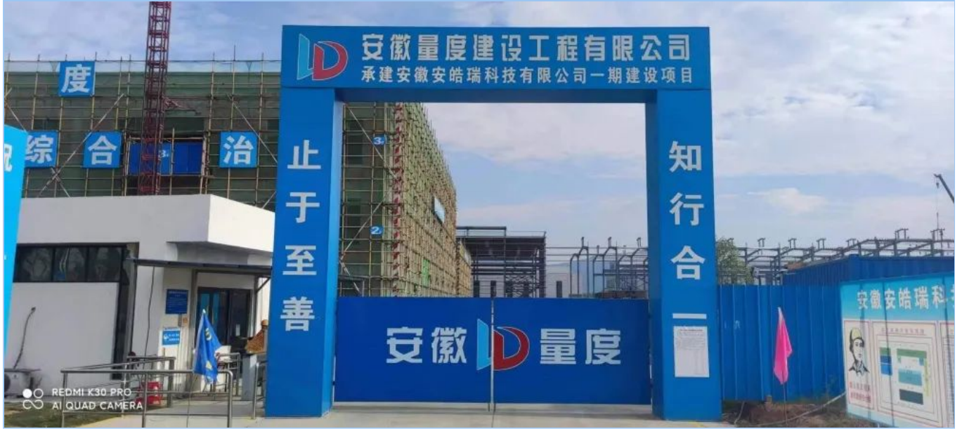
安徽安皓瑞科技有限公司年产8000万瓶（套、袋）等环保清洁材料生产项目一期
