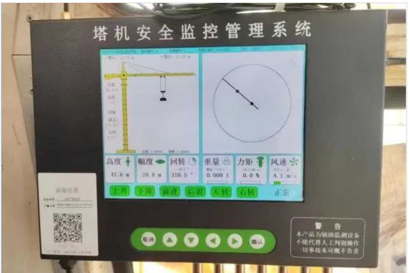
锦绣康泰城E区（三标段）项目工程
